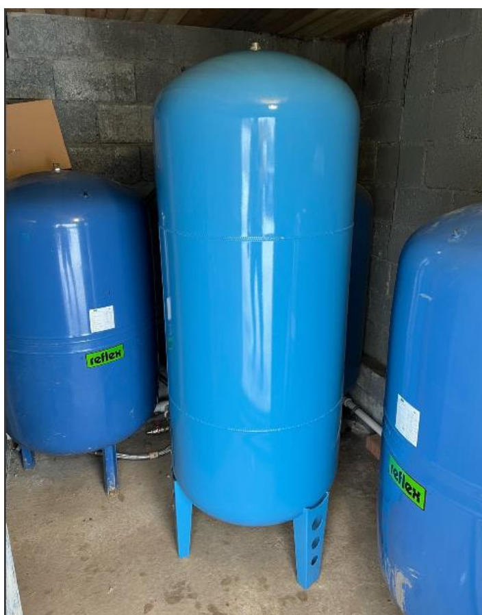
Фото 1. Установка дополнительного гидроаккумулятора
